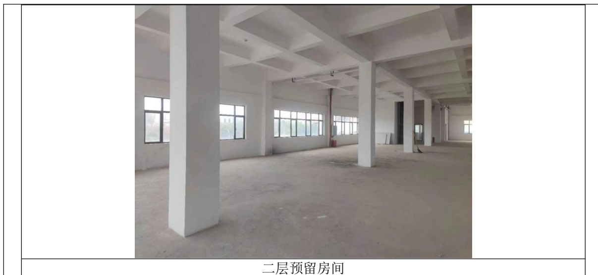
图8-2 拟建放射性药品暂存库周边情况
