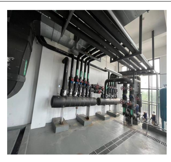
拟建放射性药品暂存库北侧
